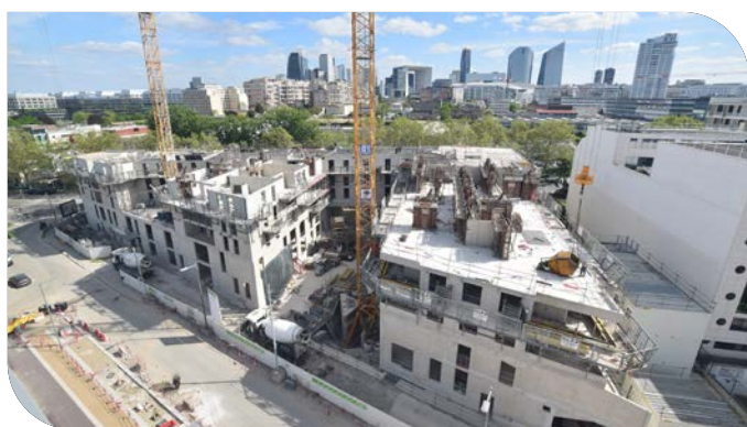
Photo des travaux
