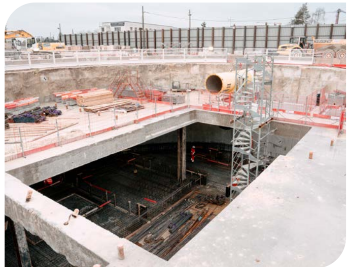
Photo des travaux
