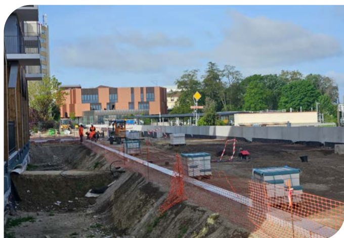
Photo des travaux
