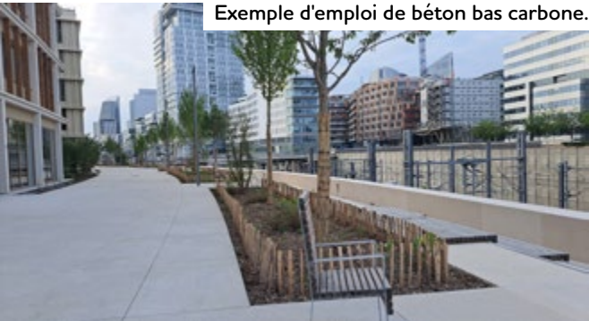
Exemple d'emploi de béton bas carbone.
