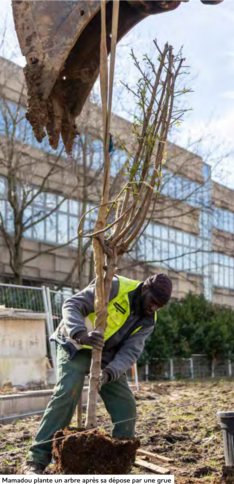
Mamadou plante un arbre après sa dépose par une grue
