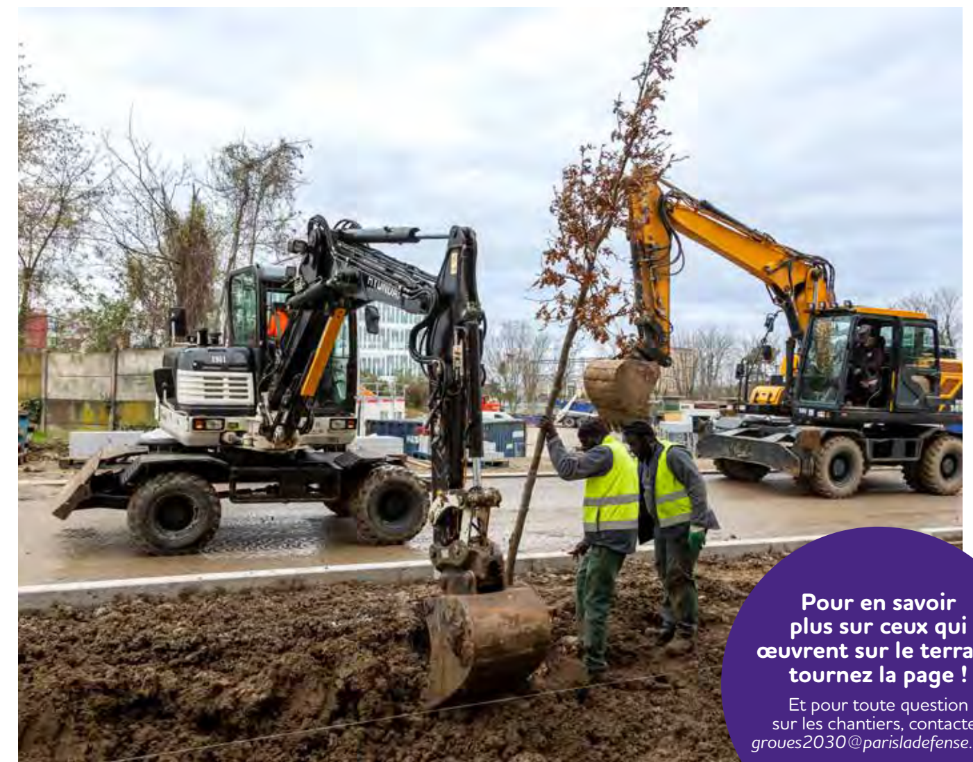
Chantier du jardin des Rails
