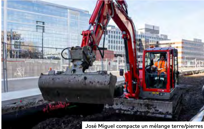
José Miguel compacte un mélange terre/pierres
