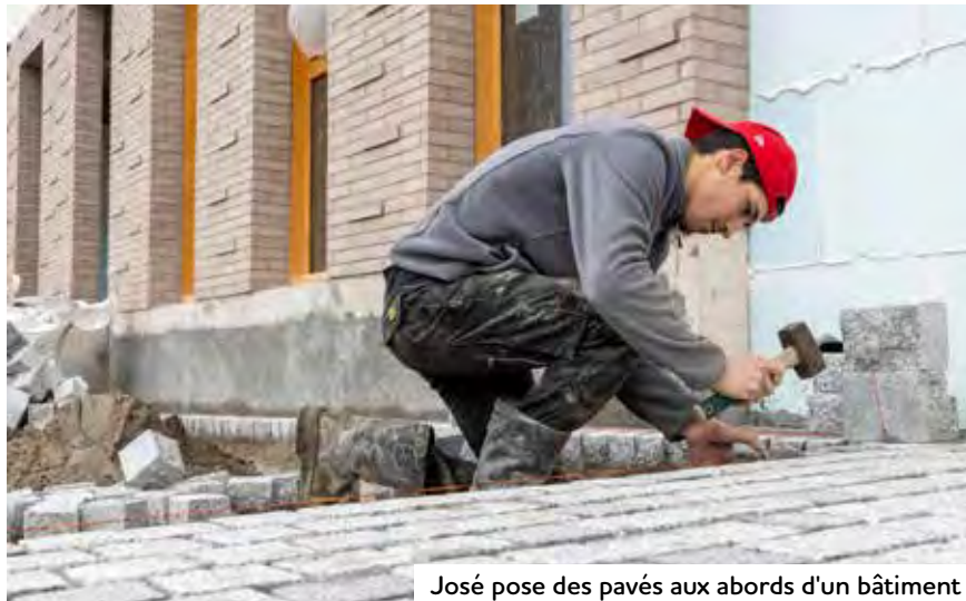
José pose des pavés aux abords d'un bâtiment
