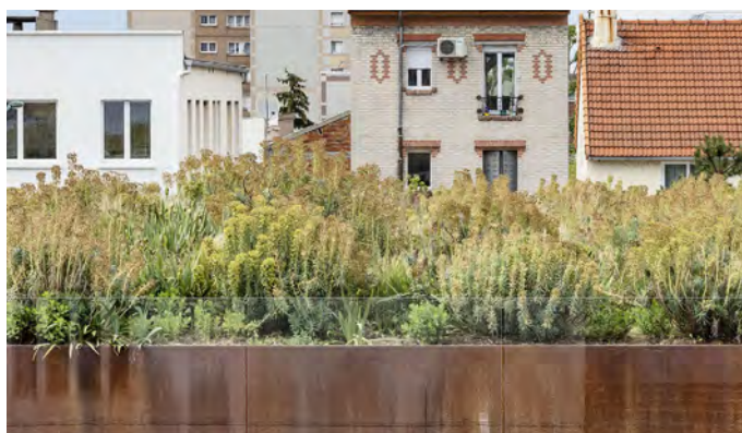
Référence de toiture végétalisée comportant 80cm de substrat. Collège Duras à Colombes (ROPA architecte, Atelier Jours paysagiste)
